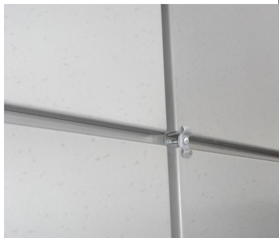
Mynd 16 Bráðabirgðafesting á klæðningu á efstu hæð í suður.
