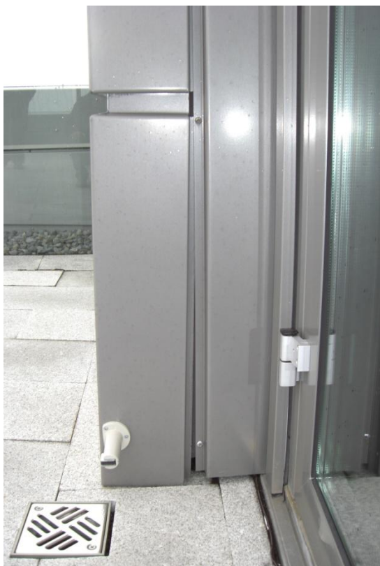
Mynd 15 Laus klæðning á efstuhæð í suður.
