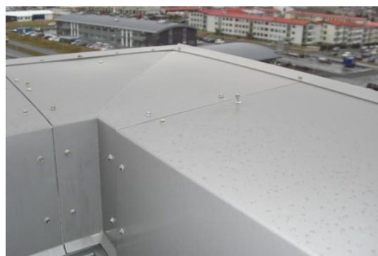
Mynd 18 Skrufur að losna í áfellum á þakkanti vesturhúss.
