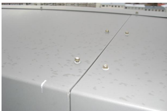
Mynd 17 Skrufur að losna í áfellum á þakkanti vesturhúss.
