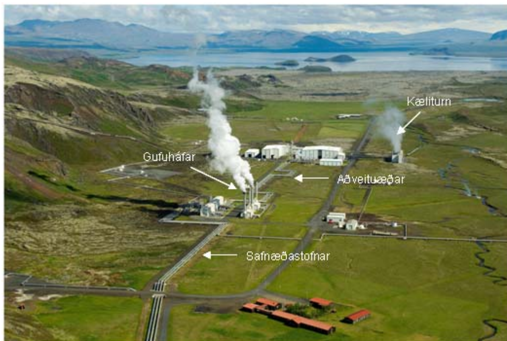
Mynd 1. Dæmi um gufuveitu. Myndin er tekin á Nesjavöllum og sýnir safnæðar að skiljustöð, gufuháfa og aðveituæðar að stöðvarhúsi. Á myndinni sjást einnig fjórir gufuháfar.
