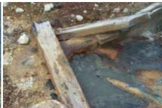
Mynd 24. Auga ofan vatnshversins í þrónni. Rauði liturinn er hugsanlega járnoxíð eða hýdroxíð. Ljósmynd 2002 TP.
